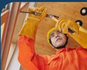
Flats & Villas Maintenance
